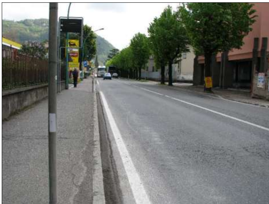
Figura 4.4 – Esempio di rilievo fotografico eseguito nel sito critico
