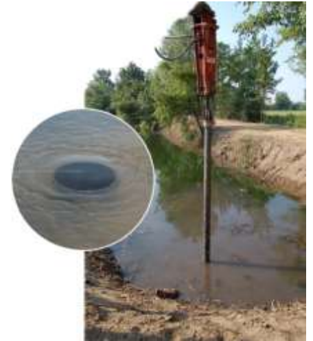
“Testa “ripulita e riprofilata e riposizionamento tubi emungitori del Fontanile Campociocci minore a Buccinasco (Mi) (ERSAF, 208)
