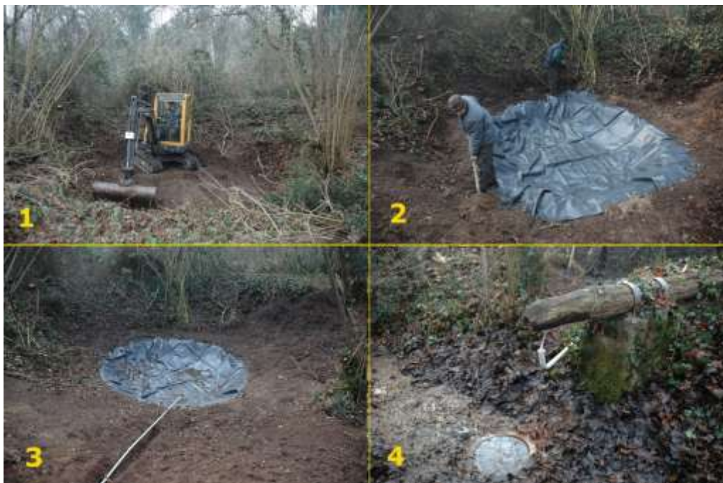
Fig. 26 Fasi di realizzazione delle pozze artificiali: 1. Scavo; 2. Impermealizzazione con teli; 3. Posizionamento del tubo; 4. Collegamento al pozzo artesiano (PROGETTO NO.IAS Bosco Fontana, MN – Foto Daniele Birtele)
