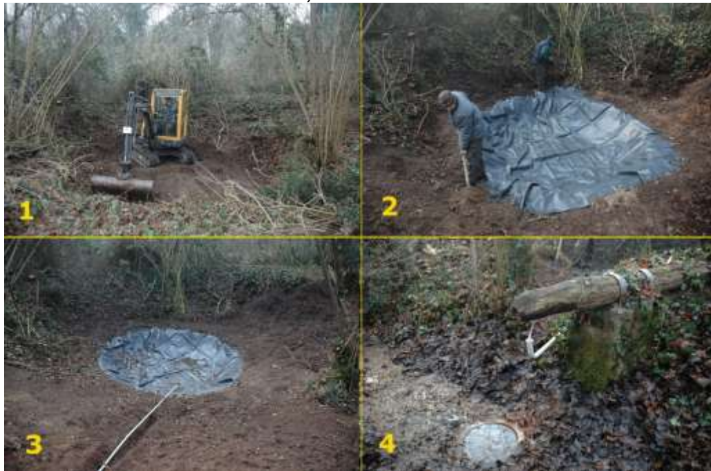
Fasi di realizzazione delle pozze artificiali: 1. Scavo; 2. Impermealizzazione con teli; 3. Posizionamento del tubo; 4. Collegamento al pozzo artesiano (PROGETTO NO.IAS Bosco Fontana, MN – Foto Daniele Birtele)
