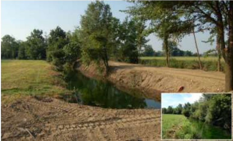
“Testa “ripulita e riprofilata e riposizionamento tubi emungitori del Fontanile Campociocci minore a Buccinasco (Mi) (ERSAF, 208)
