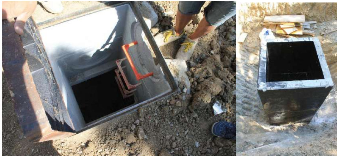
Esempi di chiusura di accessi con pozzi artificiali (Life08 NAT IT000369 Gypsum)
