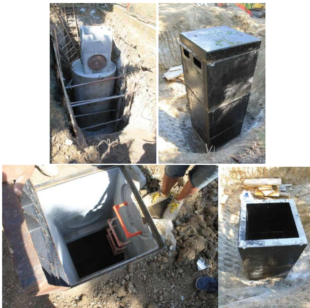
Esempi di chiusura di accessi con pozzi artificiali (Life08 NAT IT000369 Gypsum)
